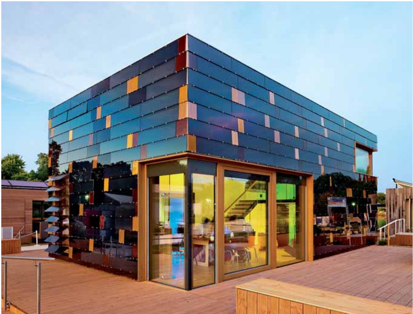
Abbildung 2 Südwestansicht des surPLUShome.
